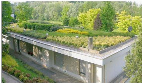
figura 6 Esempio di copertura in “tetto verde”
