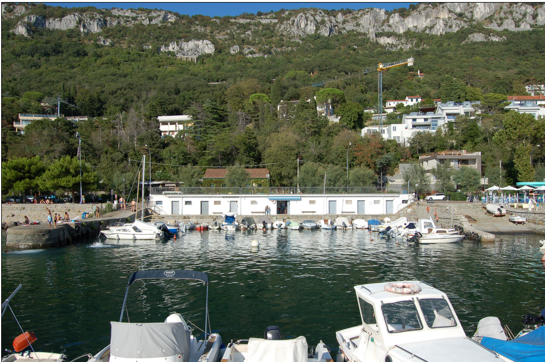
Vista frontale dal punto più esterno del molo di protezione del del porticciolo - Stato di fatto
