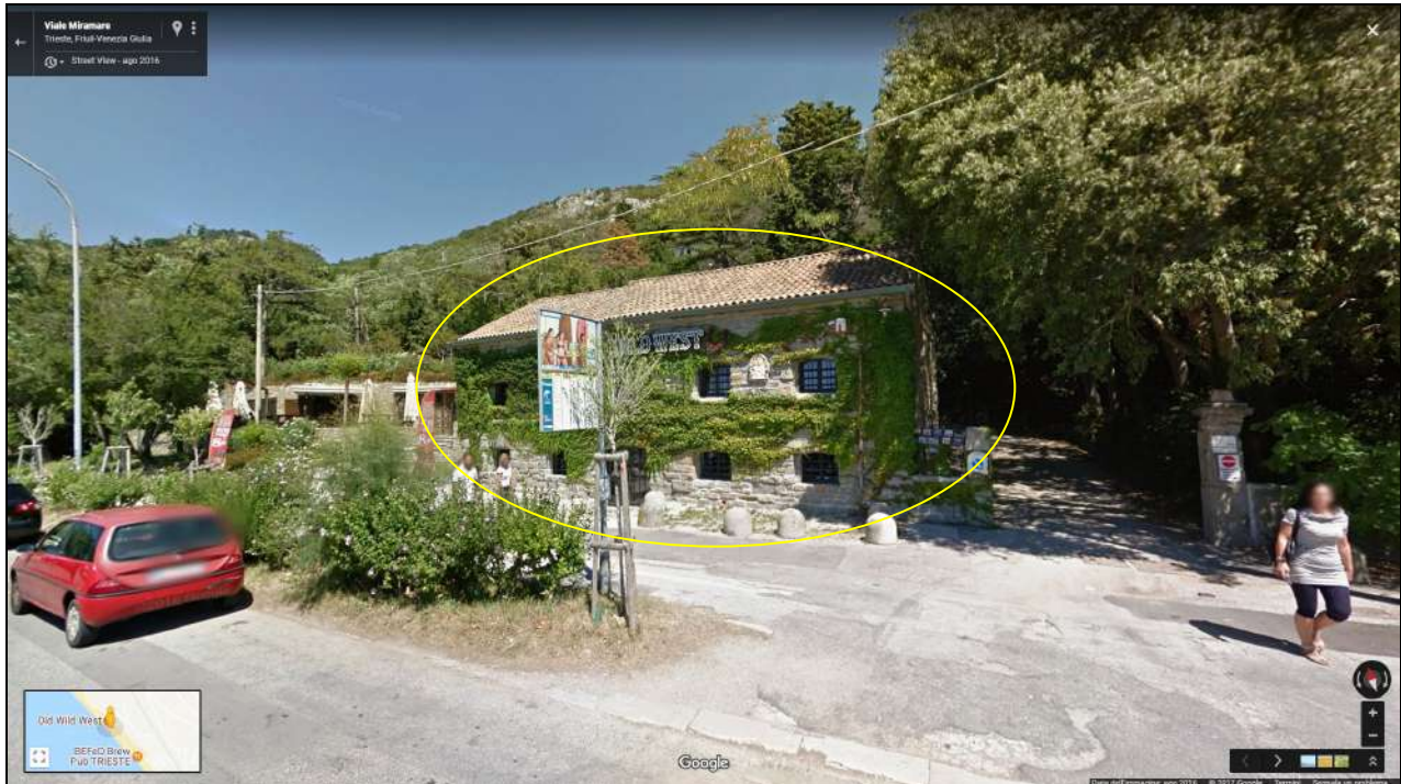
La "casetta" che ospitava la batteria di cannoni, poi adibita a deposito temporaneo di attrezzature per la pesca, oggi recuperata per attività di ristorazione; a destra l'accesso alla strada privata carrabile perimetrale al lotto d'intervento - fonte Google Street view
