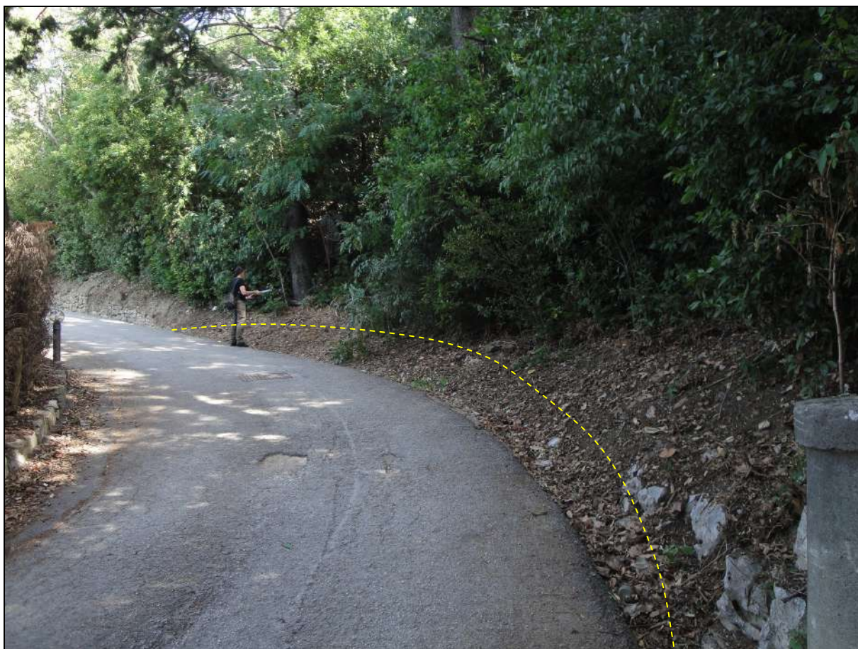
Tratto della strada interna con segnalazione indicativa dell'allargamento
