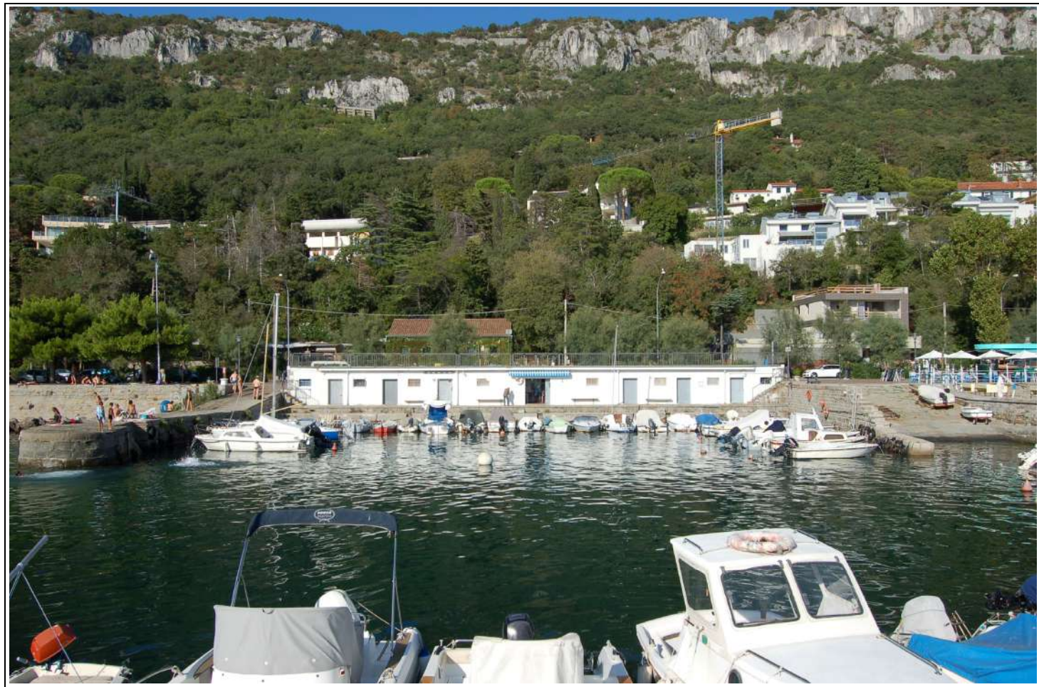
p.d.v. 1 - Stato di fatto dal punto più esterno del molo di protezione del porticciolo
