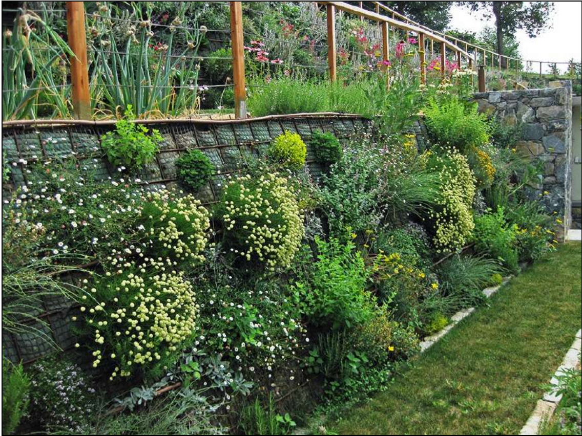
Terra armata in fase di rinverdimento
